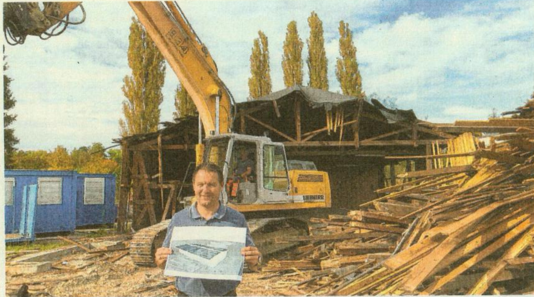
Macht Platz für Neues: Die „Jedermannhalle“ ist Geschichte, Geschäftsführer Steffen Fuchs des Bauunternehmens Hermann Fuchs freut sich auf die Möglichkeiten für seine Firma. Foto: jku
